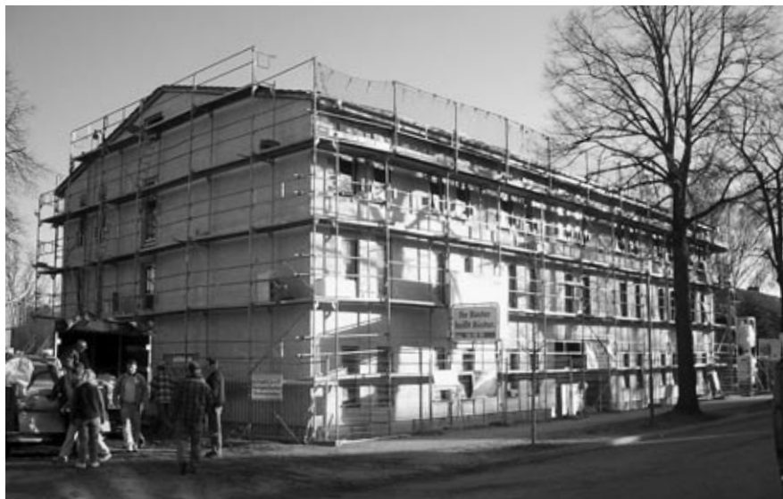
Es laufen die letzten Vorbereitungen für das Richtfest am 24. März 2004
