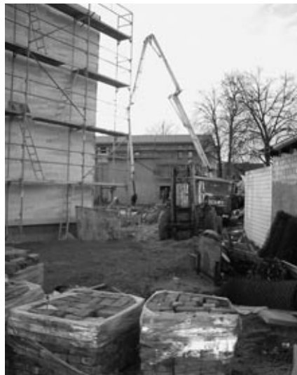
Die Bauarbeiten gehen zügig voran
