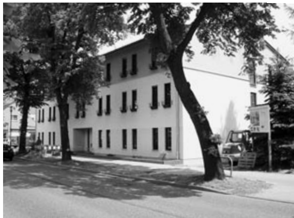
Das neue Altenpflegeheim in der Berliner Str. 33 in Großbeeren
