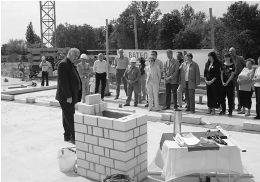
Herr Giesecke legt den Grundstein für das neue Seniorenzentrum auf dem Saalower Berg
